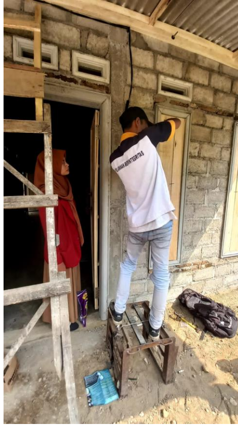
Pemasangan token listrik baru dan pengecekan besaran Kwh
