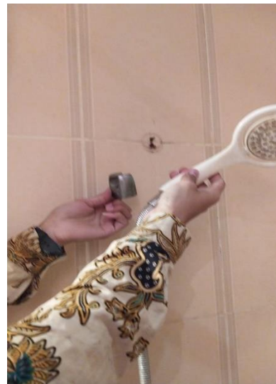
Proses pengecekan fasilitas hotel disetiap kamar
