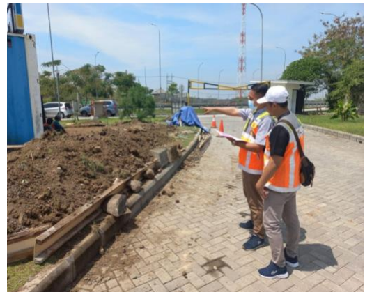
Proyek pembangunan toko ( Tenant ) di Rest Area Teras Dipa 695 B
