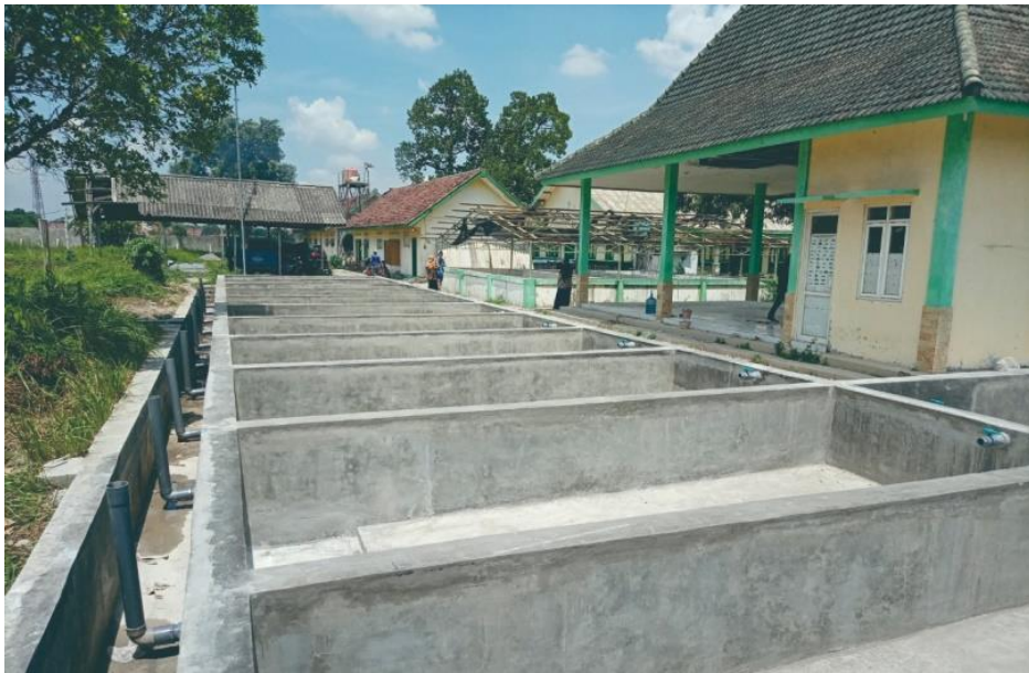
Gambar 6 (Proses Pengerjaan Rehab Kolam Pengelolaan Budaya Air Tawar)
