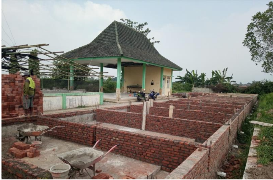
Gambar 5 (Proses Pengerjaan Rehab Kolam Pengelolaan Budaya Air Tawar)
