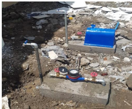
Gambar 3.1 Pemasangan Sambungan Baru
